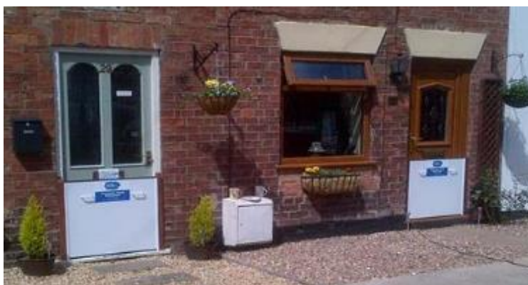
Figura 91 – Paratoie manuali a protezione di porte di ingresso
