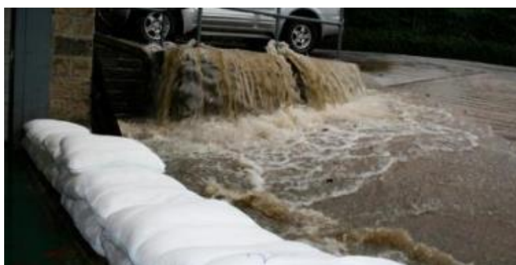
Figura 85 – Barriera temporanea in sacchi riempiti con materiale sintetico assorbente
