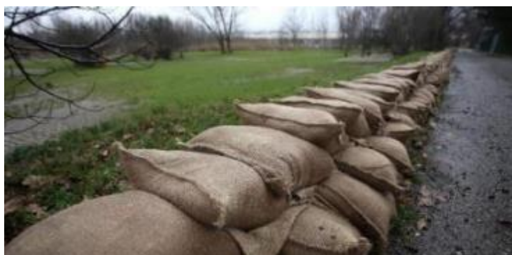
Figura 84 – Barriera temporanea antiesondazione in sacchi di sabbia
