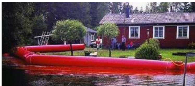
Figura 86 – Barriera temporanea antiesondazione riempita ad aria
