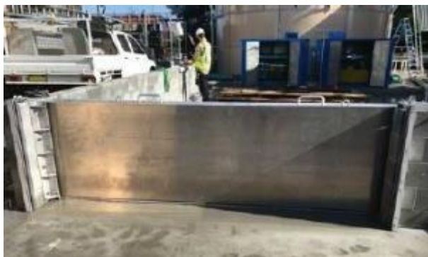
Figura 90 – Paratoia di chiusura a scorrimento orizzontale per un cancello a tenuta idraulica
