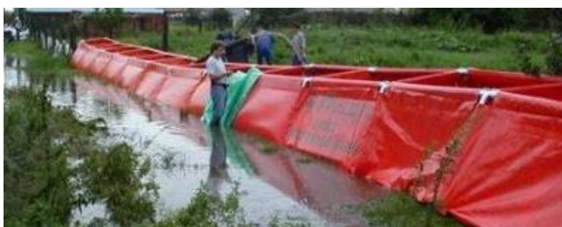
Figura 87 – Barriera temporanea antiesondazione riempita ad acqua
