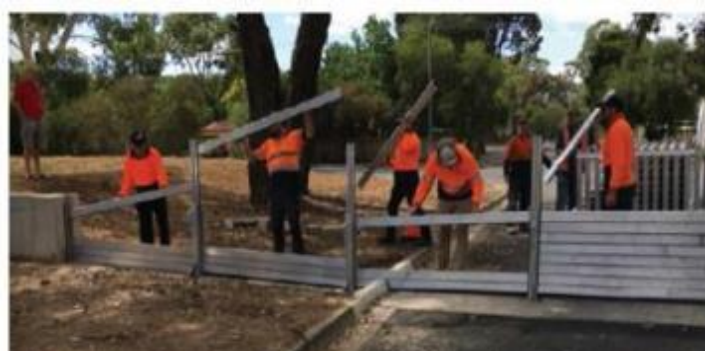
Figura 89 – Barriera temporanea modulare con pilastri e panconi manuali in alluminio
