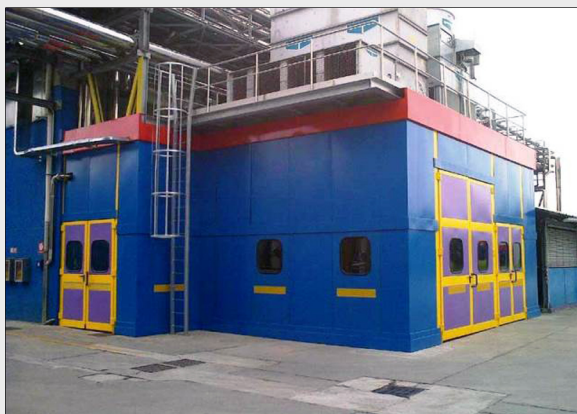
ACS DOBFAR S.P.A. Bonifica acustica compressore - Cabina silente
