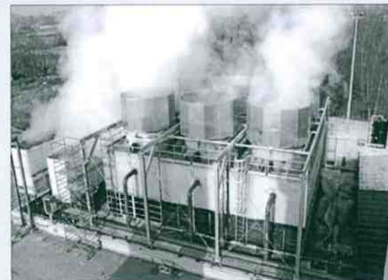
SAPIO PRODUZIONE OSSIGENO S.R.L. Bonifica acustica torri evaporative - Silenziatori e barriera antirumore perimetrale
