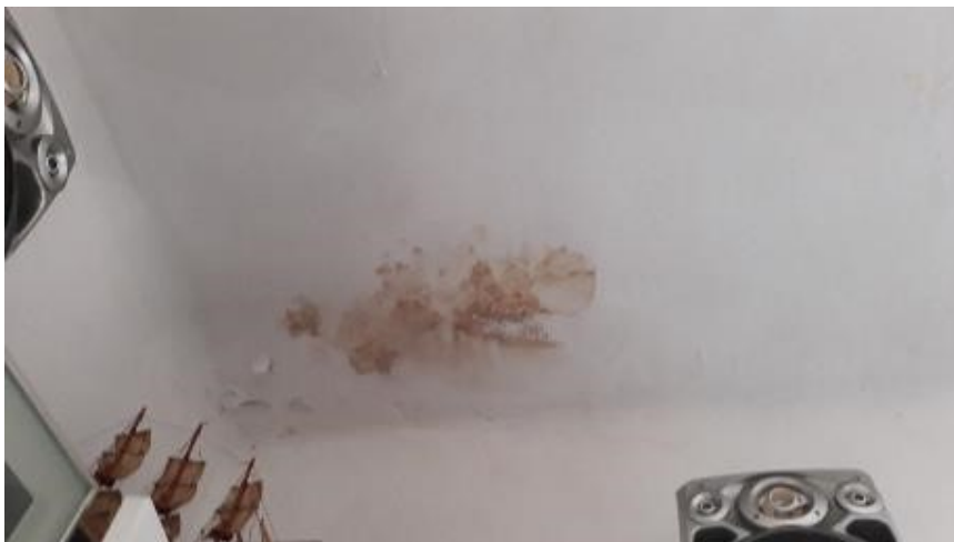
Foto 21 alloggio via Palestro n. 35-37 primo piano – infiltrazioni acqua piovana
