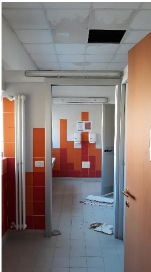
Foto 9 - 10 Scuola Primaria G. Mazzini infiltrazioni acqua e crollo parziale controsoffitto
