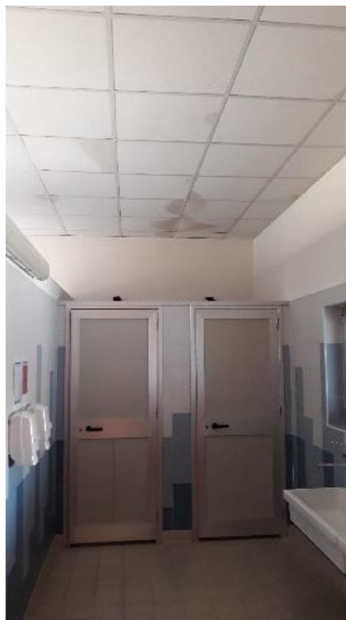
Foto 9 - 10 Scuola Primaria G. Mazzini infiltrazioni acqua e crollo parziale controsoffitto
