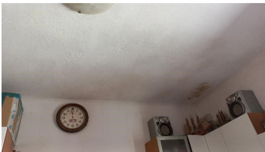
Foto 22 alloggio via Palestro n. 35-37 primo piano – infiltrazioni acqua piovana
