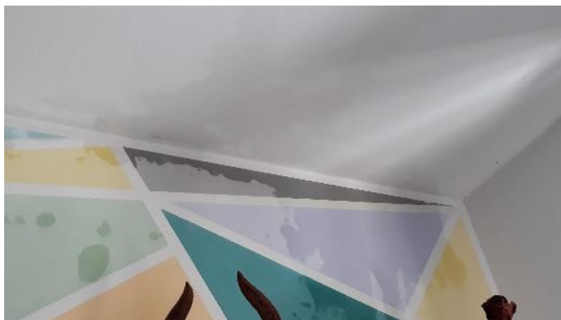
Foto 14 alloggi vic. Taverna civ. 124 – infiltrazioni acqua piovana
