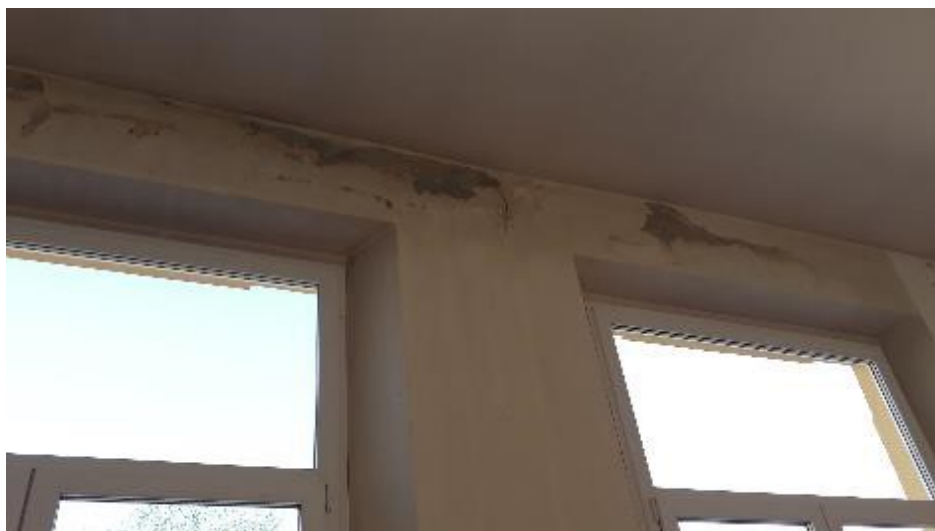
Foto 11 Scuola Primaria G. Mazzini infiltrazioni acqua con distacco intonaco
